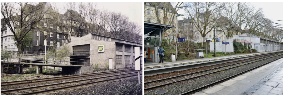
Abbildung 3.15: DO · DB · 01 Nahverkehrsbahnhof Dortmund-Möllerbrücke, Autogarage in der Bahnböschung. Die Bahnstrecke wurde elektrifiziert und ein völlig neuer Bahnhof gebaut. Die Wohnhäuser in der Umgebung wurden modernisiert. Die Autogarage an der Bahnböschung ist dieselbe, die Zufahrt wurde an die Ostseite verlegt. (Quelle: Scharioth und Schräpler 2017)
