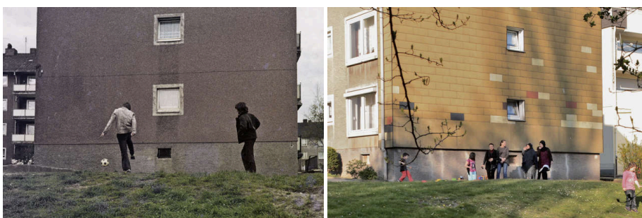
Abbildung 3.33: GLA · BR · 13 Einfaches Mietwohnhaus der 50er-Jahre. Das Wohnhaus hat inzwischen eine »kleine Modernisierung« durch neue Fenster und einen Wetterschutz an der Giebelwand erhalten. Viele Bewohner sind Familien mit türkischen Wurzeln. (Quelle: Scharioth und Schräpler 2017)
