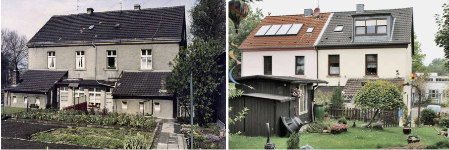
Abbildung 3.13: BO · WE · 09 Doppelhaus. Die Häuser sind Teil einer früheren Werkssiedlung nahe der Zeche Prinz Regent. Die Bewohner haben die Häuser schon vor Jahrzehnten von einer großen Wohnungsbaugesellschaft gekauft und seitdem individuell modernisiert und die Dächer ausgebaut. Aus den Nutzgärten sind Freizeitgärten geworden. (Quelle: Scharioth und Schräpler 2017)
